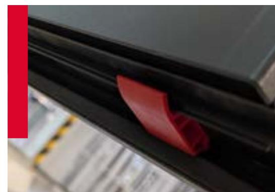
**4.** Nettoyer les profils du dormant et de l'ouvrant, ainsi que le seuil, en éliminant tout dépôt éventuel d'enduit, de mortier, de mastic ou de poussière, et s'assurer que les trous d'évacuation d'eau du seuil ne sont pas obstrués.
